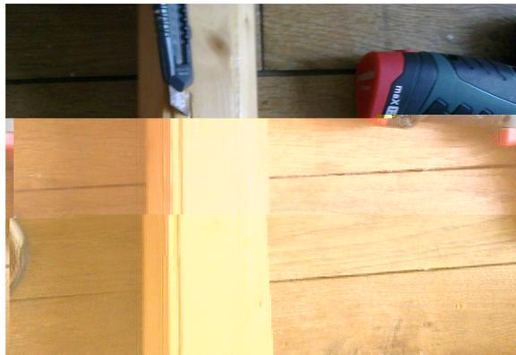
Là maintenant... étape cruciale ! Bloquez votre fissure avec une perceuse faite un trou a chaque extrémité de la fissure. Cela évitera une élongation de la fissure
